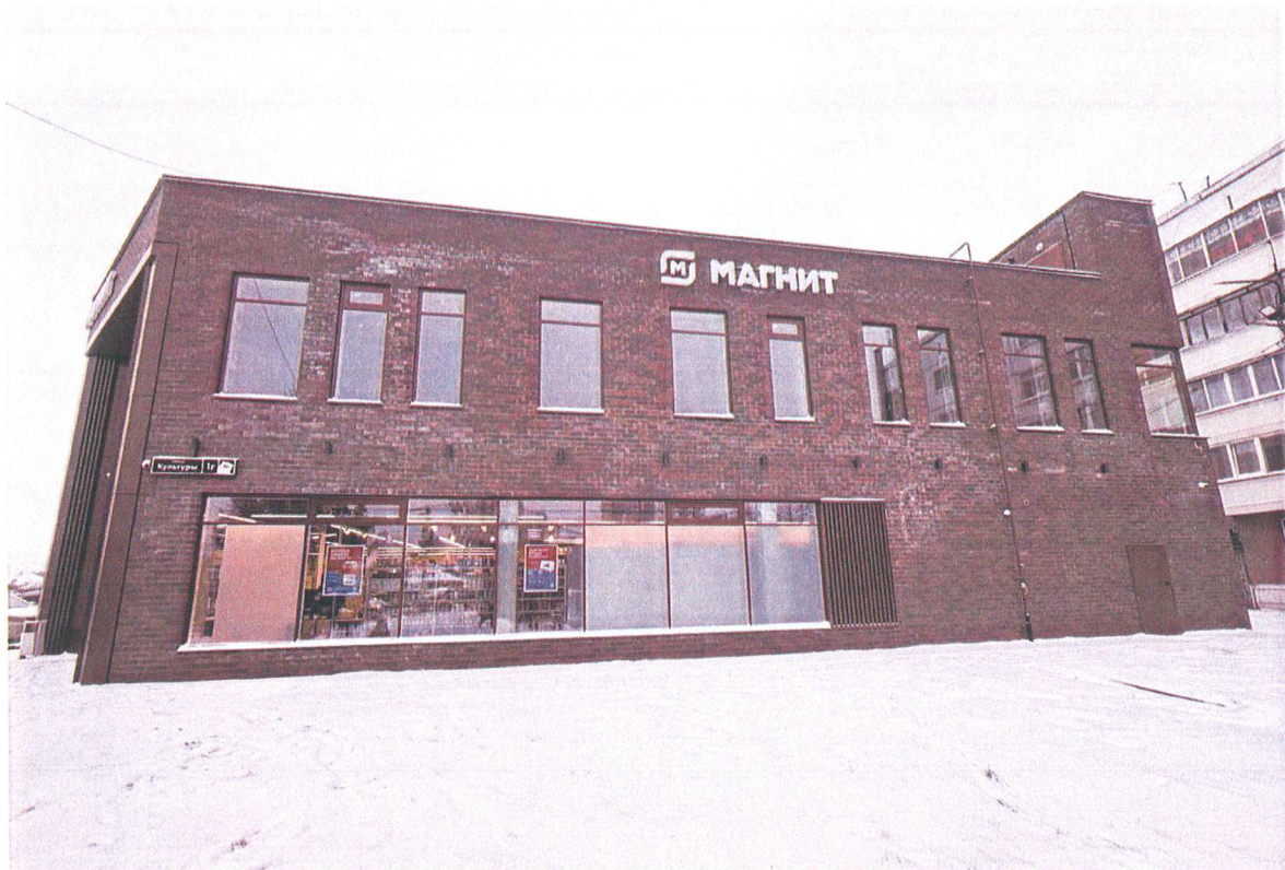
Существующее состояние главного фасада
