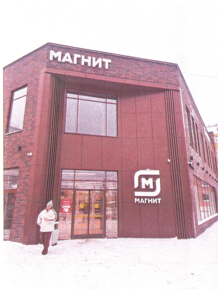
Существующее состояние главного фасада
