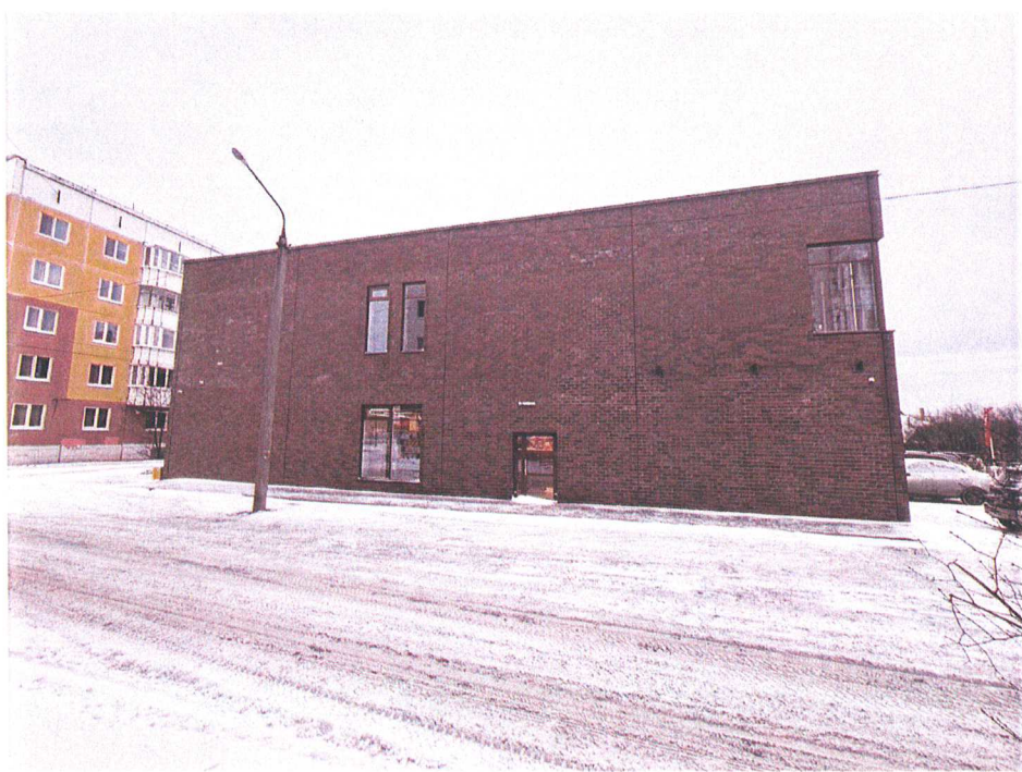
Существующее состояние бокового фасада
